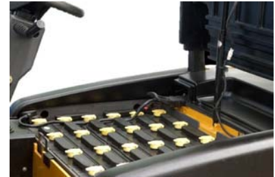
48 volt AC control system
